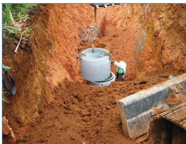
Photo 2. Pose de regard
