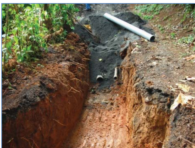
Photo 1. Travaux d'extension de réseau (gravitaire et refoulement)
