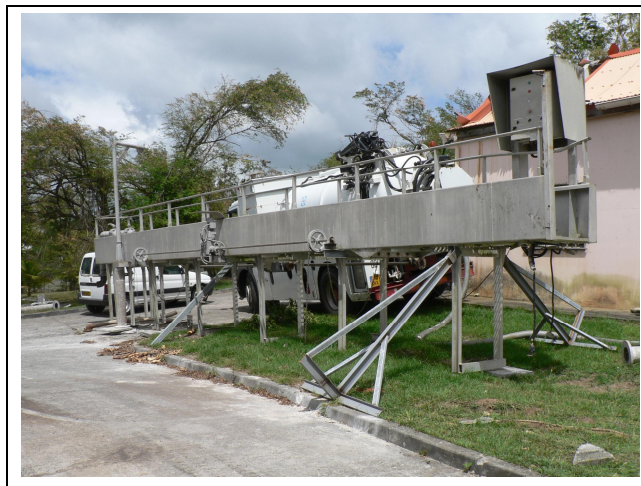
Photo 1. Poste de relevage
