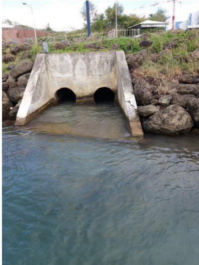
Rejets pluviaux dans le port de plaisance
