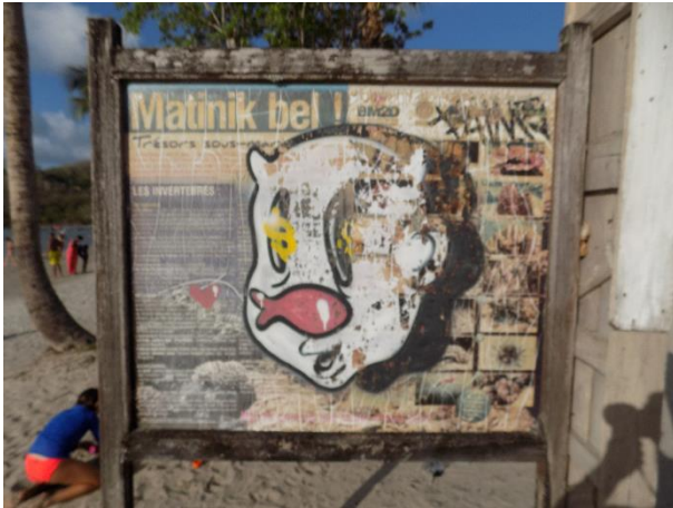
Vétusté et dégradation de certains panneaux d'affichage
