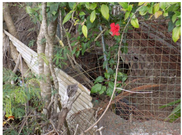
Rejet suspect dans la ravine
