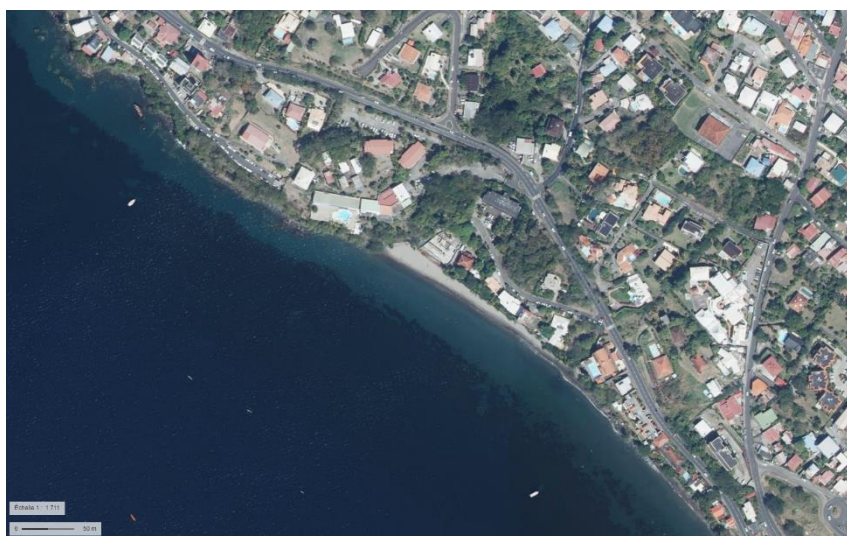
Figure 15 : Photographie aérienne de la baignade du Lido
