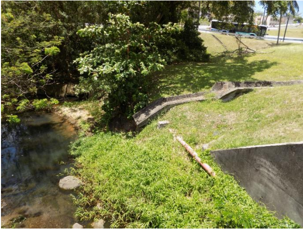
Exutoire d'eaux pluviales de la rivière Fond Nigaud
