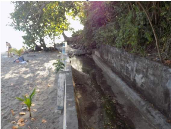
Figure 77 : Exutoire d'eaux pluviales à l'entrée de la plage du Lido
