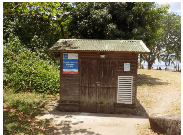
Poste de refoulement Madiana plage
