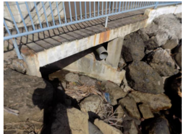
Figure 74 : Exutoire d'eaux pluviales au Sud de la plage
