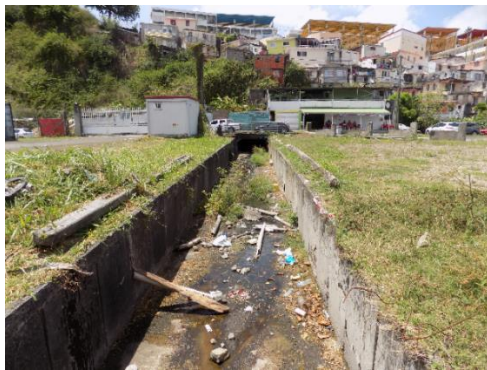
Exutoire d'eaux pluviales
