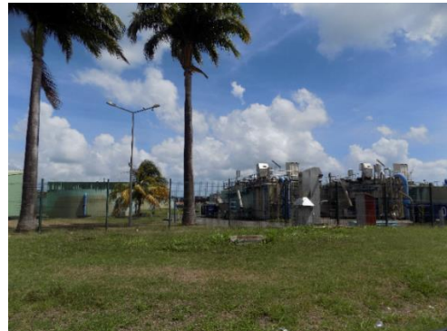
Station d'épuration Dillon 1&amp;2
