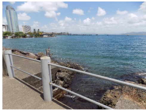
Exutoire d'eaux pluviales
