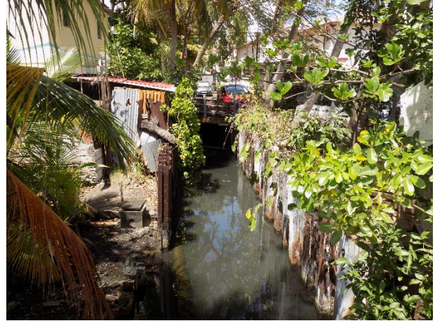
Ravine déversant dans la baie des Tourelles
