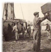
Carénage à Concarneau, vers 1815 (source : « Laniec.com » n°5, février 2012)
