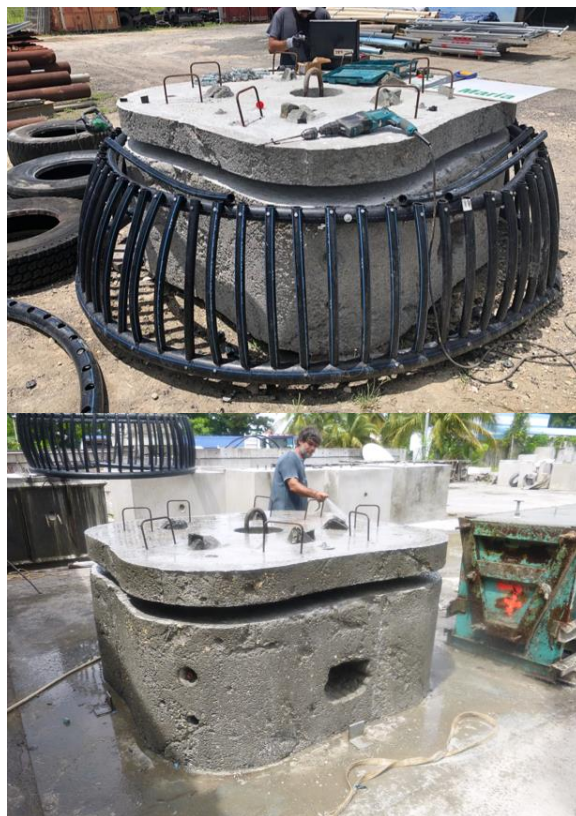
Figure 61 : Corps-morts écoconçus dans le cadre d'une halte plaisance à Bouillante, en Guadeloupe
