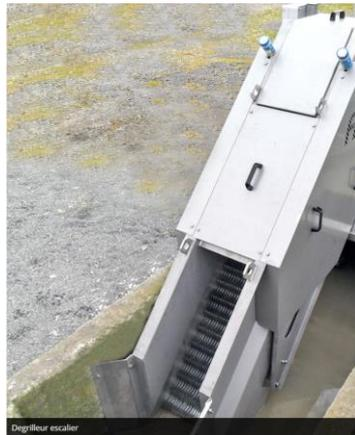
Figure 30 – Photo d'un dégrilleur escalier
