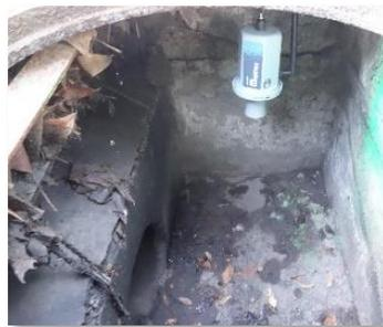
Figure 9 – Capteur de remplissage (source : SERAMM)
