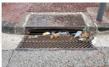
Figure 7 – Barreaudage installé sur un avaloir existant à Marseille (Source : SERAMM)
