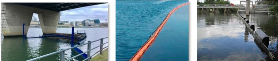
Figure 39 – Exemples de barrages flottants
