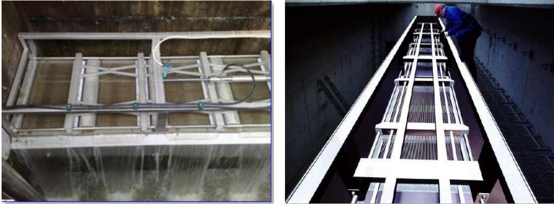
Figure 37 – Photo et schéma d'un dégrilleur horizontal à transfert de déchets
