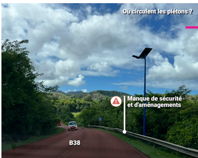
Manque de sécurité piétonne sur la route D38 à la sortie de l'Anse Mitan
